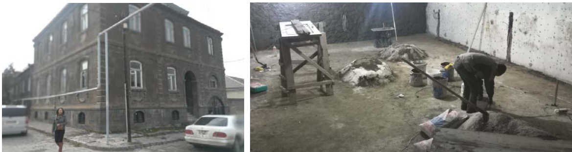
Travaux à la maison des apprentis à Gumri.
